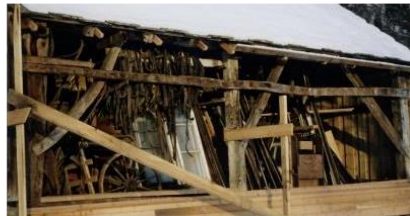
Løa ventar på ny kledning. Ein ser grindbyggstrukturen.
