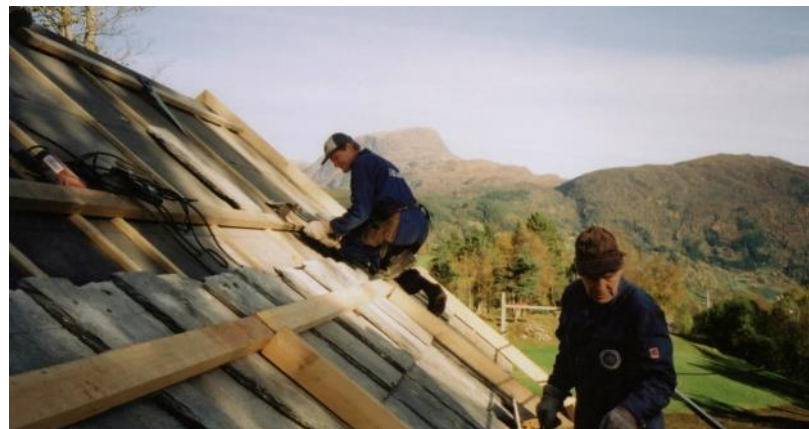
Arbeid med nytt rastatak på stovehuset.
