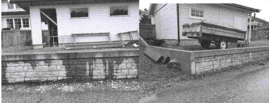
Mur til nabo, langs Moldekleivmarka, mur som det søkes om er tilsvarende denne muren
