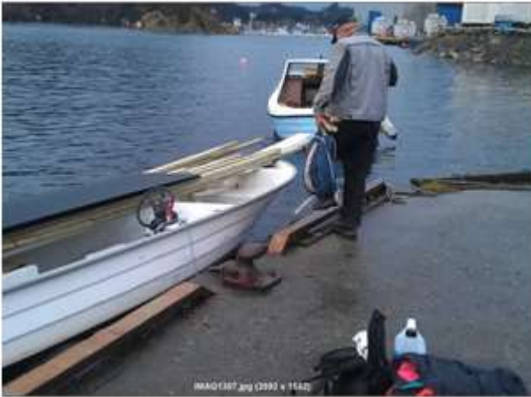
Frakt av byggematerialer med båt
