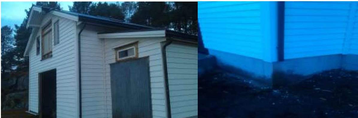
Front /fasade mot vest er skifta ut i sin heilheit. Ringmur er støypt ny.
