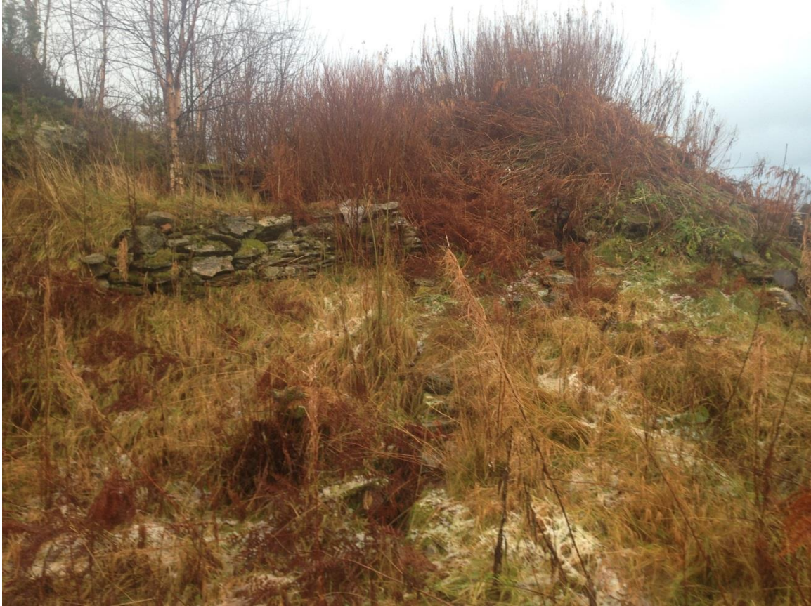
Foto 7. Restar etter tørrmur og oppmurt eldre vegfar på 22/69. NV
