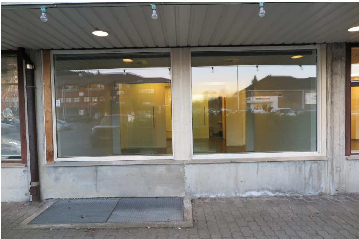
Innsyn til kontora i nordre del. Tekjøkken og toalett i bakgrunnen.
