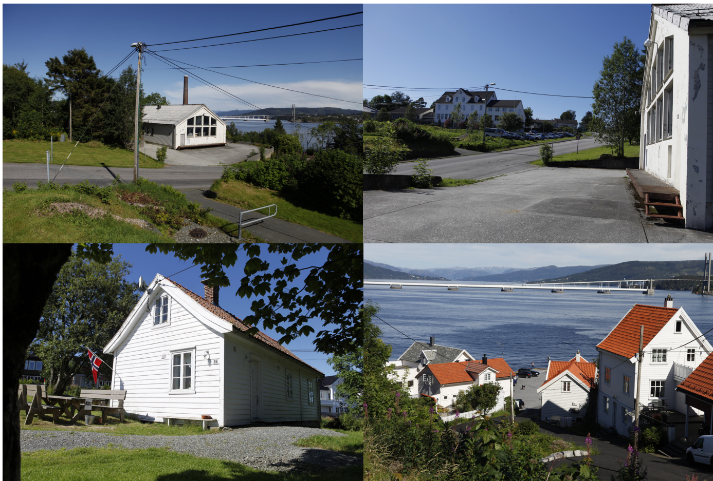
Figur 9. Øvst til venstre, meieriet sett frå Meland ungdomsskule. Øvst til høgre motsett veg Nede til høgre er Havnebrekka. Siste bilde er av Sjurshuset/Pilgarden.
