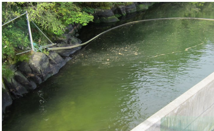
Foto 1: Bruk av lense og silduk for å hindre flyt av feittpartiklar blanda med støv og anna ut i Rosslandspollen.
