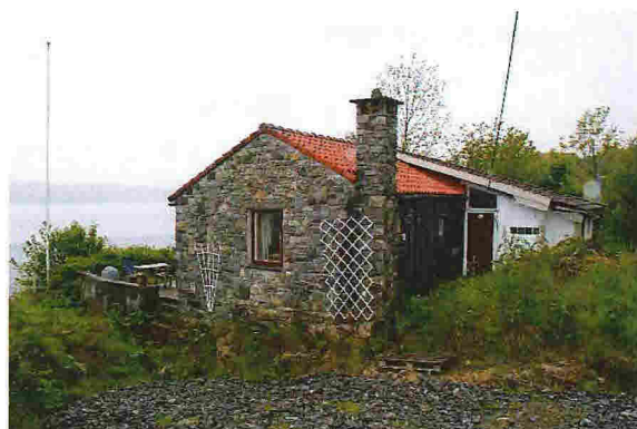
Eksisterende hytte sett fra nordøst
