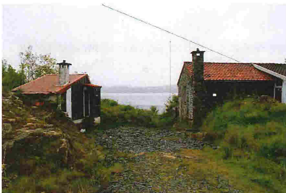
Eksisterende hytte sett fra nord
