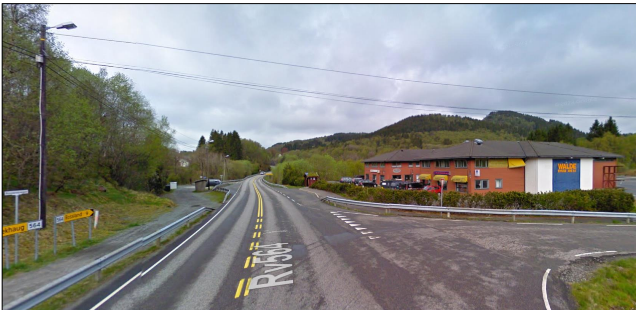
Figur 3 Dagens situasjon sett frå aust.
