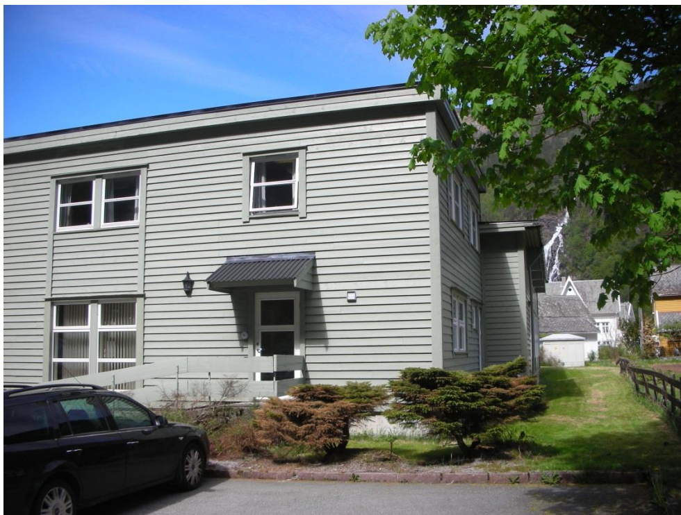
Ende mot Bryggeslottet og bakside. Ingen rømning fra 2.etg, kun via hovedtrapp
