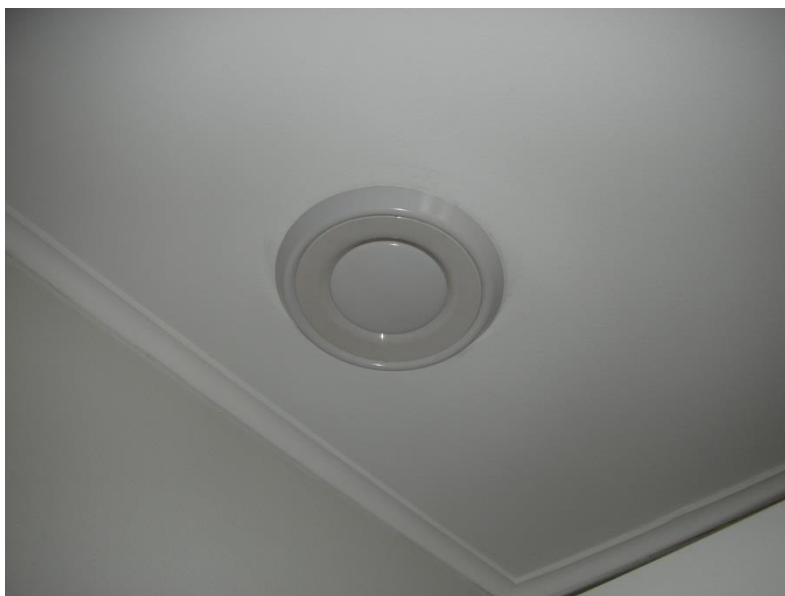
Avtrekksventil - stengt
