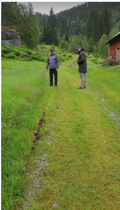
Figur 2 bilder av veg og stikkrenne
