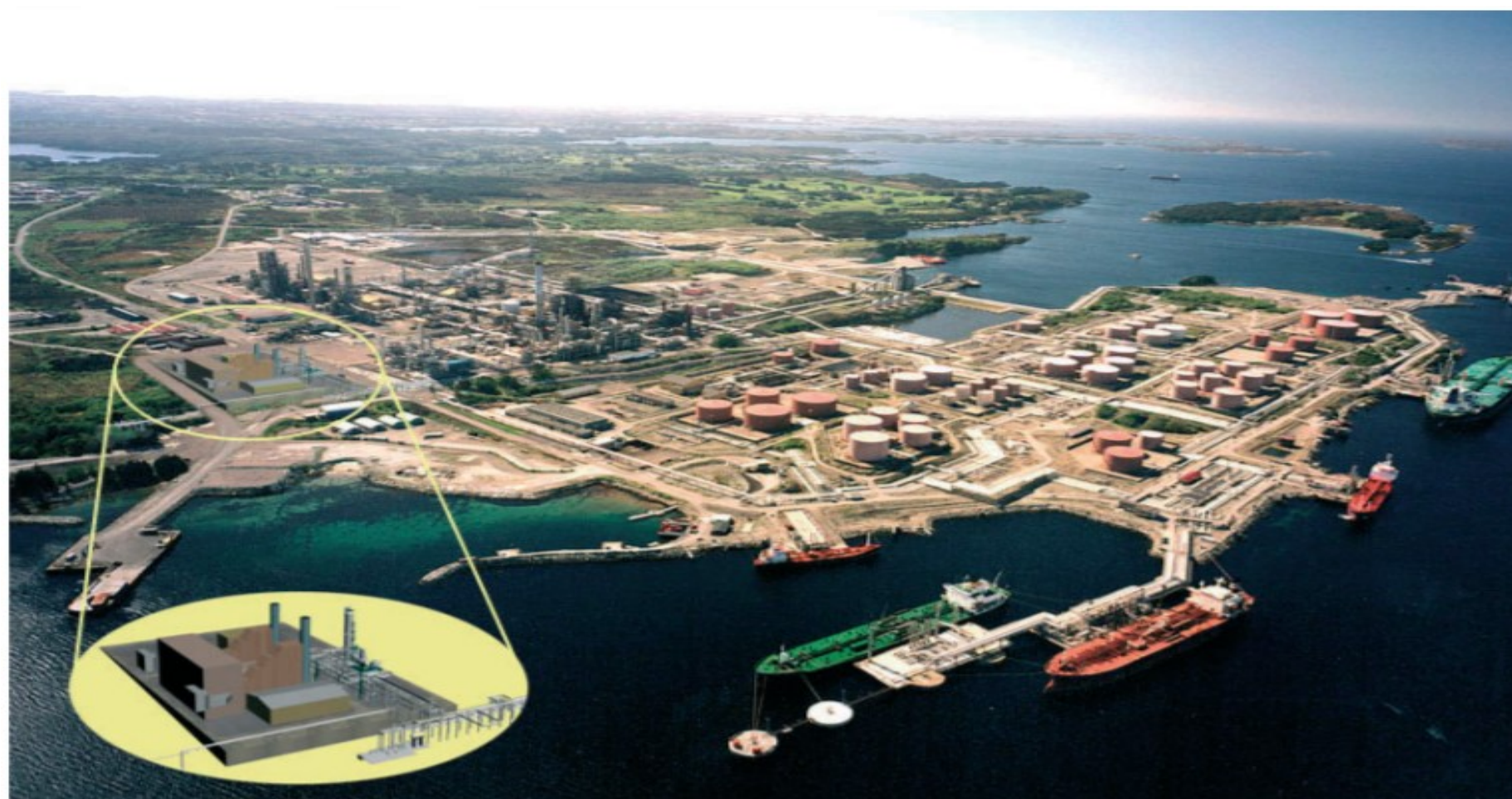
Energiverk Mongstad Kraftvarmeverk med tilhørende ombygginger i raffineriet Konsekvensutredning
