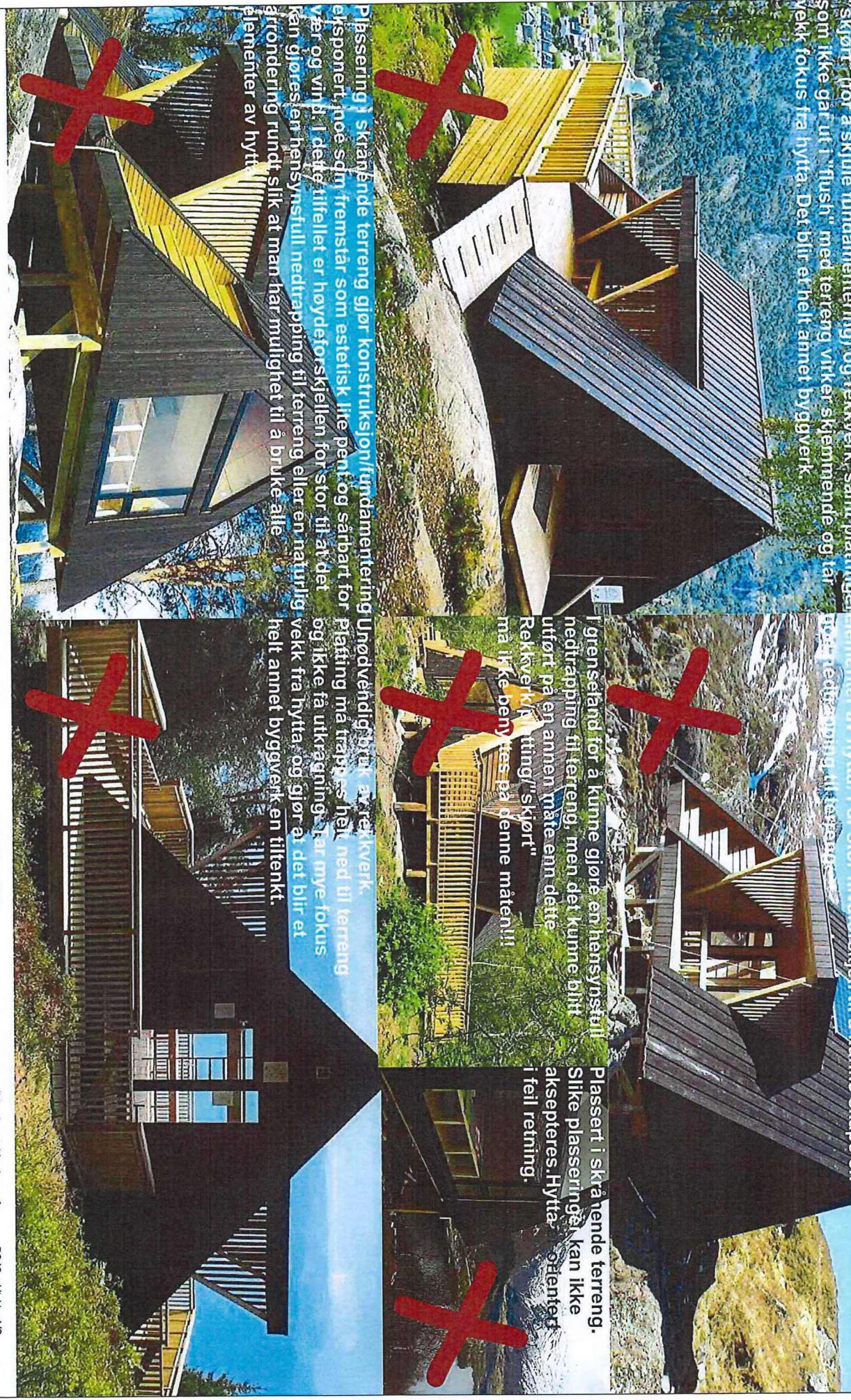
Plassering i skrående terrenget gjør konstruksjon/fundamentering eksponert, noe som fremstår som estetisk ikke pent og såbart for ver og vind. I dette tilfellet er høydeforskjellen for stor til at det kan gjøres en hensynstfull nedtrapping til tereng eller en naturlig arrondering rundt, slik at man har mulighet til å bruke alle elementer av hytta.
