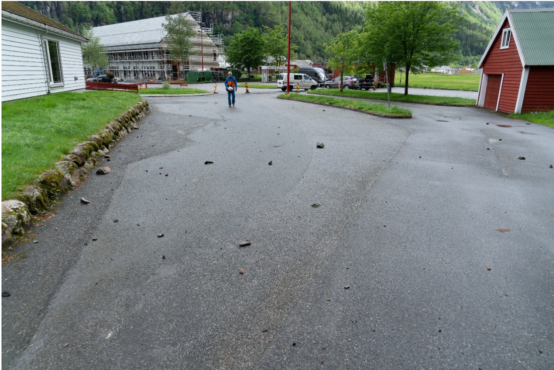
Figur 3-3. Steinsprut utover vei langs østsiden av bygget.
