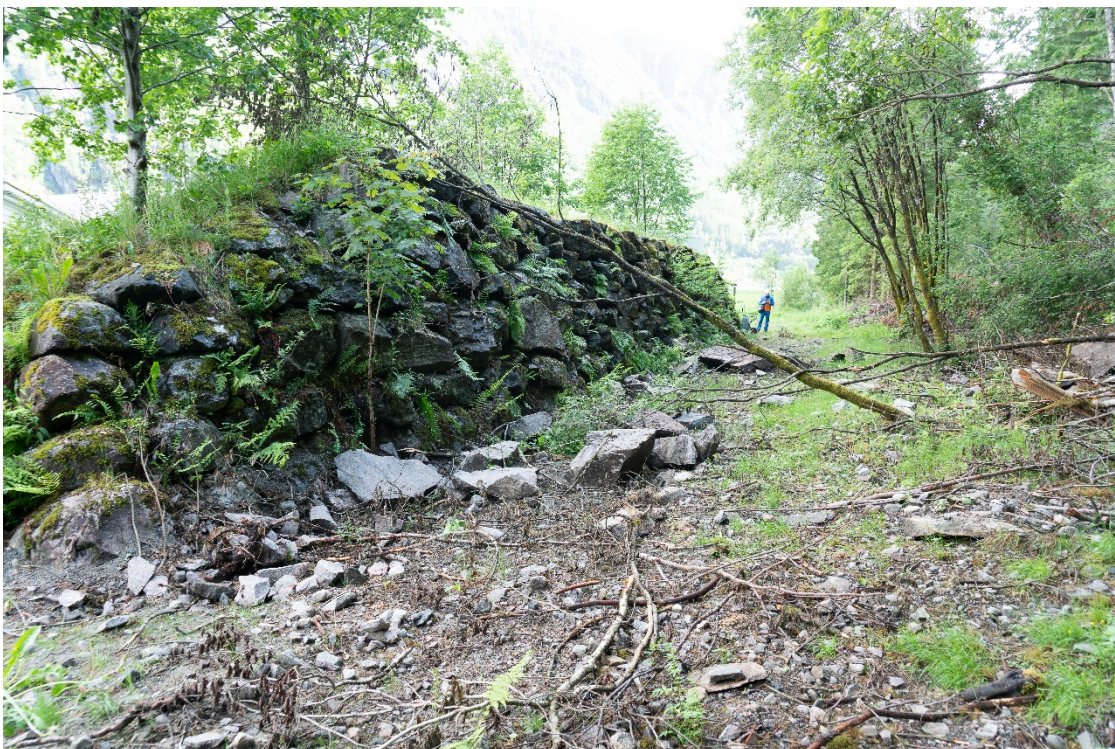
Figur 3-8. Det mest av større blokker ble fanget opp bak vollen.
