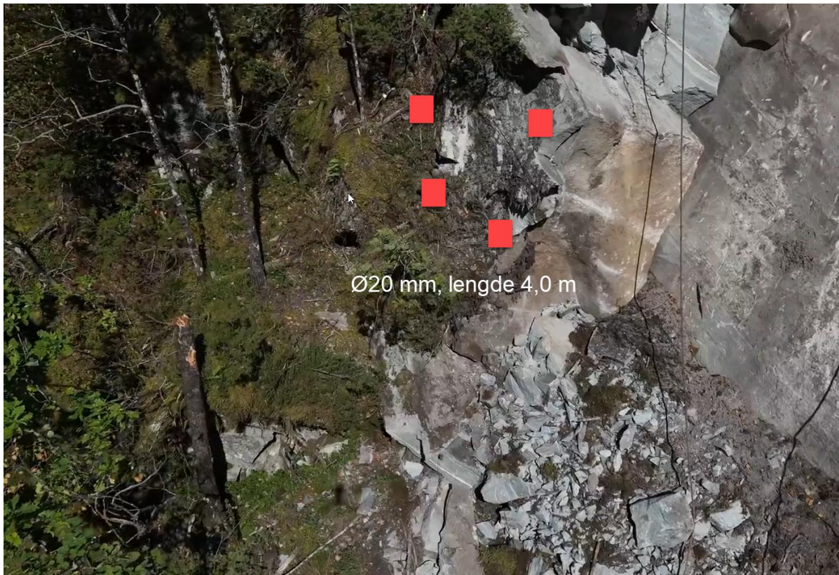
Bilde 4. Bergparti sikres med Ø20 mm endeforankrede bolter med lengde 4,0 m. Området nedenfor anvist sikring må kontrolleres og renskes.
