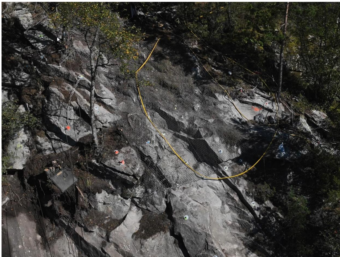
Bilde 6. Det er utført sikringstiltak med bolter, fjellbånd, wirenett og steinsprangnett i øvre del av skredløpet.
