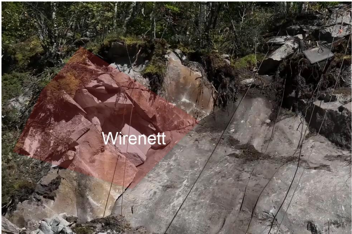
Bilde 2. Gjenstående bergparti etter sprengning sikres med wirenett som anvist på bildet. Videre installeres det Ø20 mm bolter på skrå inn i glideplanet under, se bilde 3.
