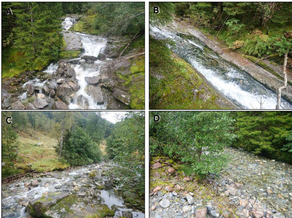
Figur 13. A & B: I store deler av den berørte strekningen er elva svært bratt. C & D: Ned mot planlagt kraftstasjon er elva litt mindre bratt med grovt substrat.
