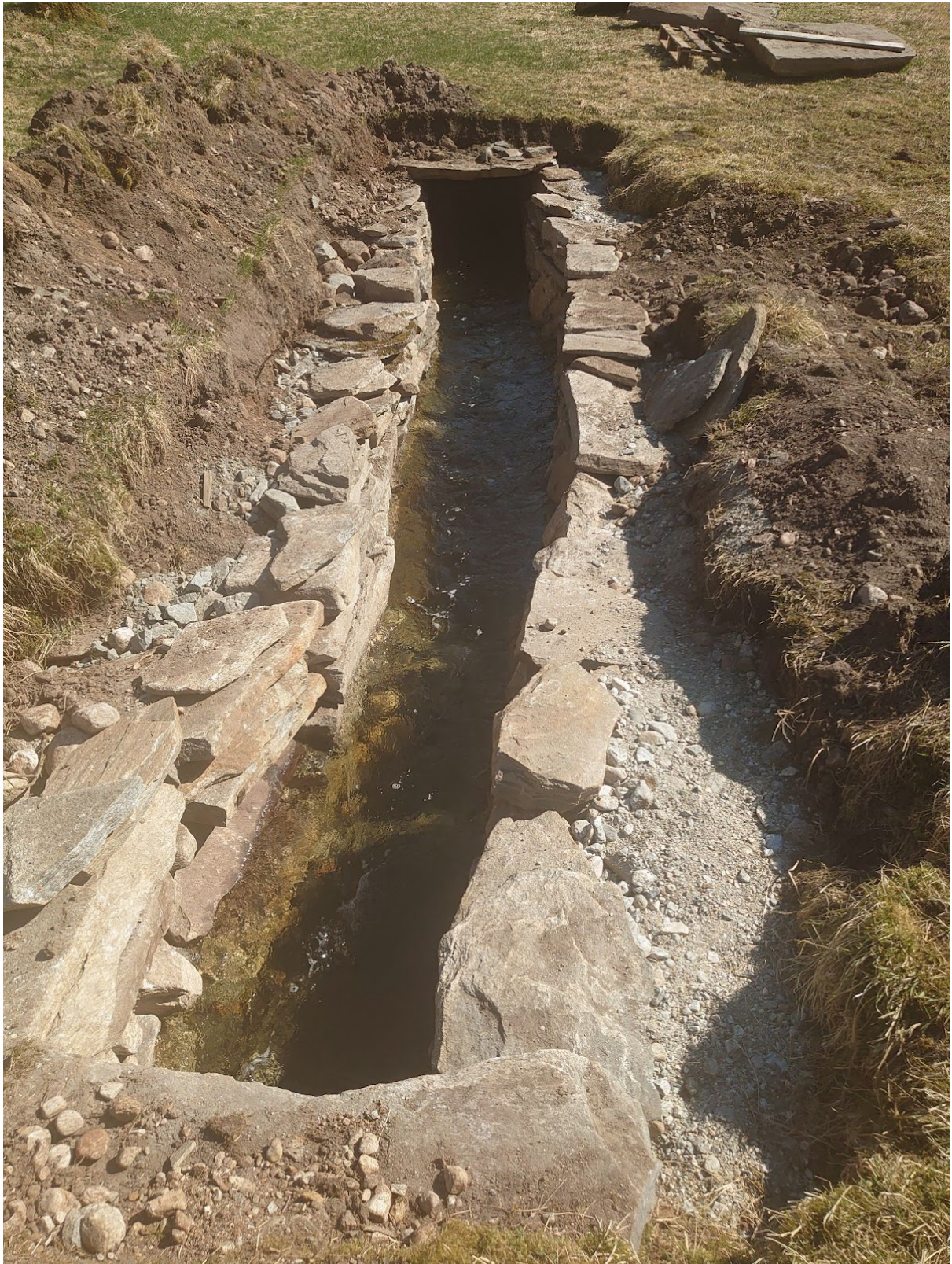
-22 april 2022. Arbeidet med muren er stort sett ferdig. Det meste av steinen kunne brukast omatt. Noko ny passende stein er funne i nærområdet og køyrt til.
