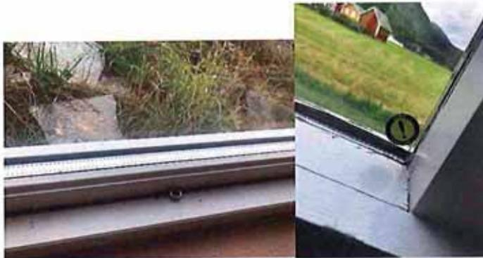
Det er ikke usansynlig at det ved riving kan avdekkes eldre fugemasser utover hva som er nevnt. Ved rivingsarbeider må eldre fugemasser samles opp og leveres som klorparafiner. Klorparafiner brukes blant annet som bindemiddel i PVC-plast, som flammehemmere i plast, gummi og tekstiler, og som mykgjørere i plast, gummi og maling.
