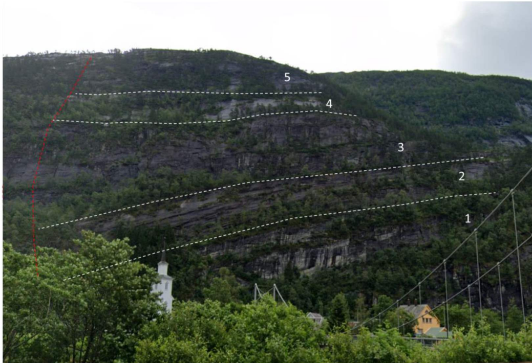
Figur 5. Definerte soner med varierende kildepotensial for steinsprang. Sone 1, 3 og 5 har vertikale, kryssende sprekkesystemer, som er gunstige for steinprangaktivitet. Bilde: Google maps.
