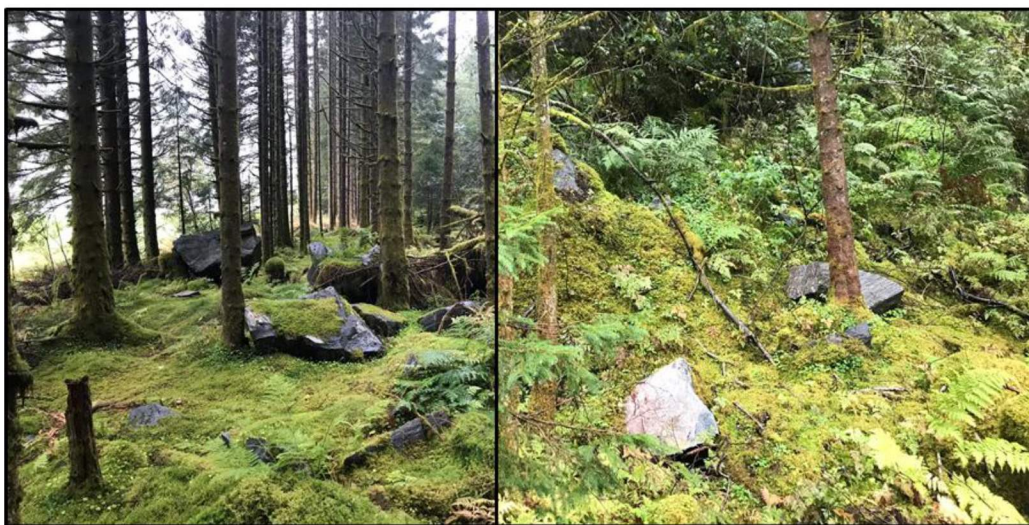
Figur 8. Flere blokker på bakken og som lener seg mot trær vitner om hyppig steinsprangaktivitet i nederste del av fjellsiden mot Mo sentrum.
