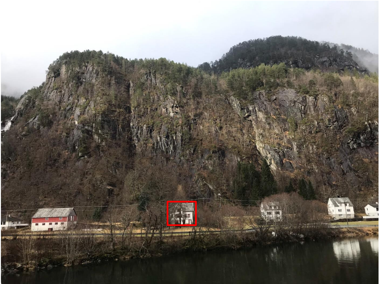
Figur 10 Oversiktsbilde mot aktuell fjellskjæring tatt fra broen som krysser Moelva. Det aktuelle huset er markert med rød firkant.
