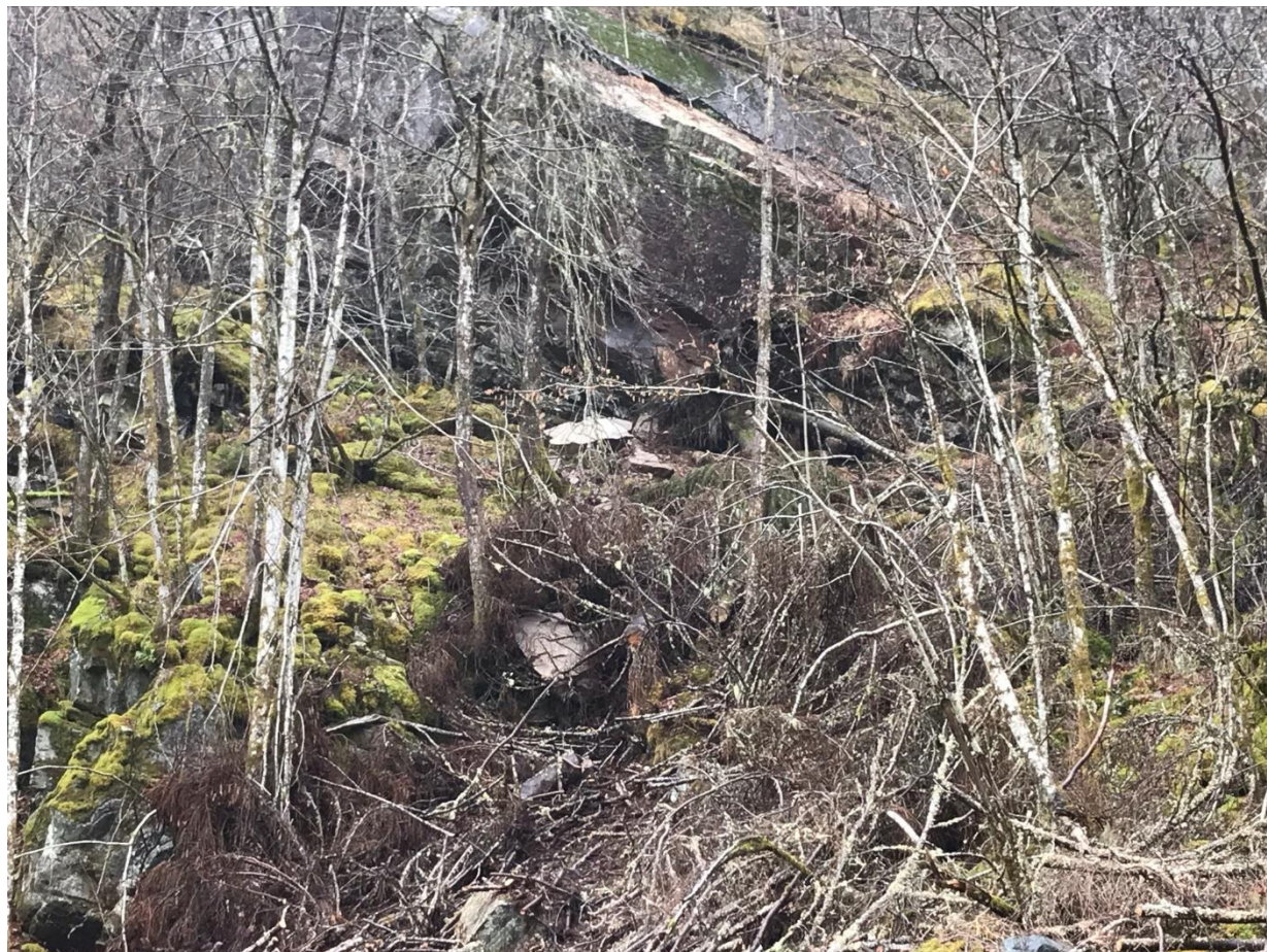
Figur 2. Ferske skredblokker observert under befaring, vist som lysesteiner.
