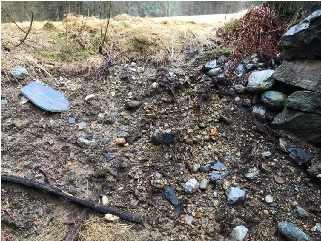
Figur 15 Løsmasser i foten av terrassen som bygget skal stå på. Massene er dårlig sortert og godt rundet, som indikerer elveavsetninger.
