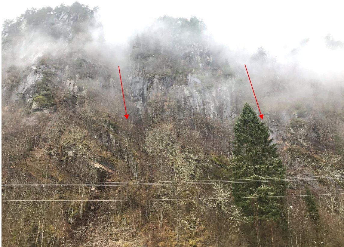
Figur 13 Potensielle dreneringsveier i fjellsiden markert med rød pil. Aktuell bygning er omtrent rett bak der bildet er tatt fra.
