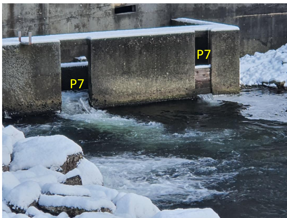
Figur 8. Fisketrappas innhopp består av to åpninger med bjelkestengsler. Øverst: Vannføring overføres fra avløpstunnelen over til trappas nederste kulper (oransje pil). Resipienthølen er dyp og godt egnet som dagstandplass for gytevandrende laks og sjøørret. Nederst: Vannføringen ut fra fisketrappas innhopsåpninger gir markerte stimuli også ved høyere vannføringer og vannstander (foto: M. Kraabøl).
