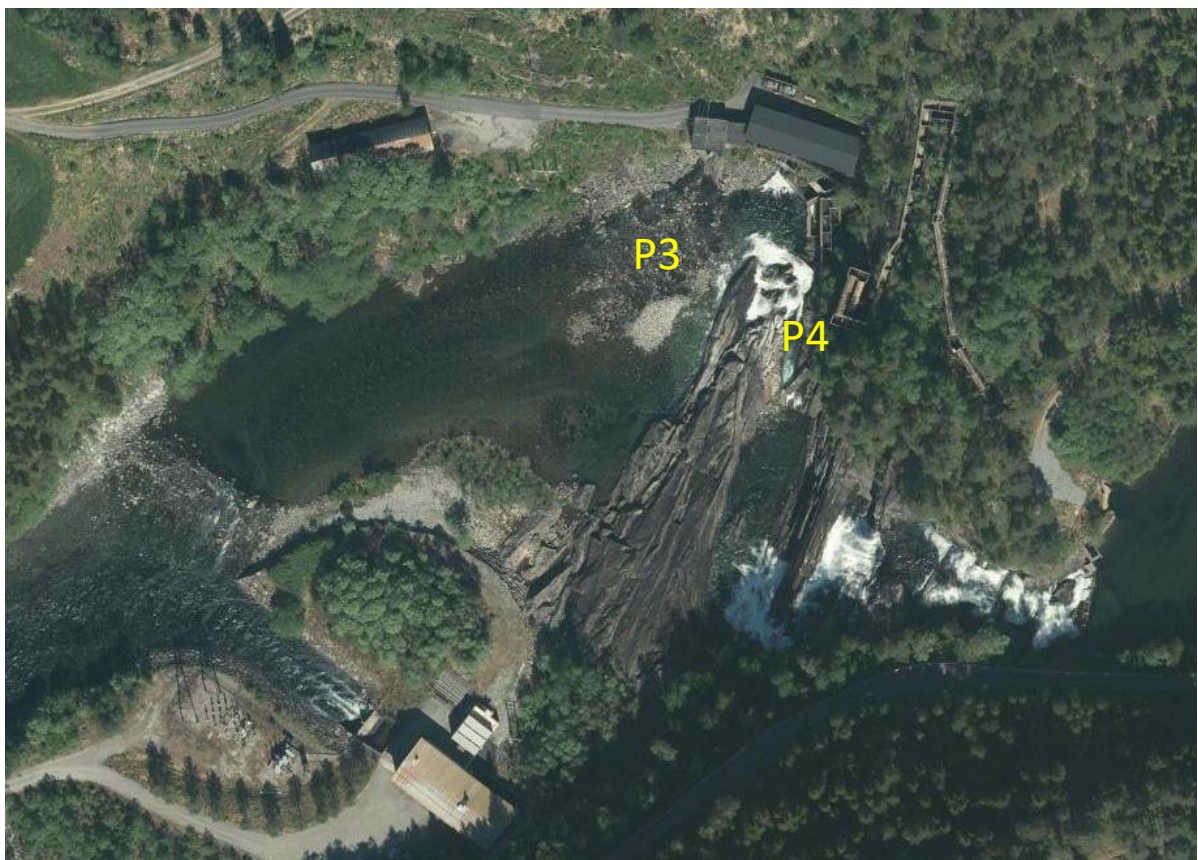
Figur 6. Oversikt over regulert elvestrekning mellom kraftverksutløpene. Potensielle problemområder nedstrøms resipientkulpene (P3) og ved fossefoten (P4) er markert (norgebilder.no)
