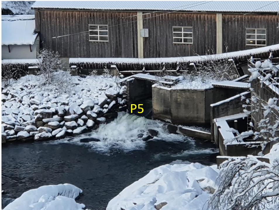
Figur 7. Utløp fra kraftverk er midt i bildet, mens utløp fra fisketrappa ses til høyre i bildet (bildet er tatt fra østsiden). Begge vannveiene munner ut i felles resipientkulp (foto. M. Kraabøl).
