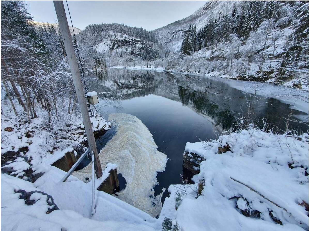
Figur 3. Inntaket til Hellandsfossen kraftverk. Inntaket er innfelt i omkringliggende bergformasjoner. Damanlegget (som vist i Figur 2, øverst) er lokalisert noen få meter til høyre i bildet (foto: M. Kraabøl).
