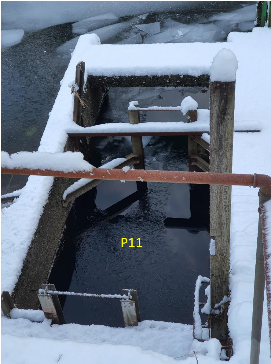
Figur 12. Teknisk installasjon og lukeføringer ved trappas vanninntak/uthopp (foto: M. Kraabøl).
