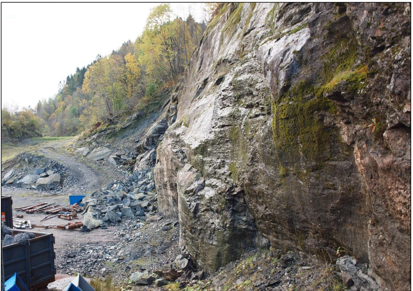
Fig 18. Skrent som må sprenges bort for å utvide lagringsareal.
