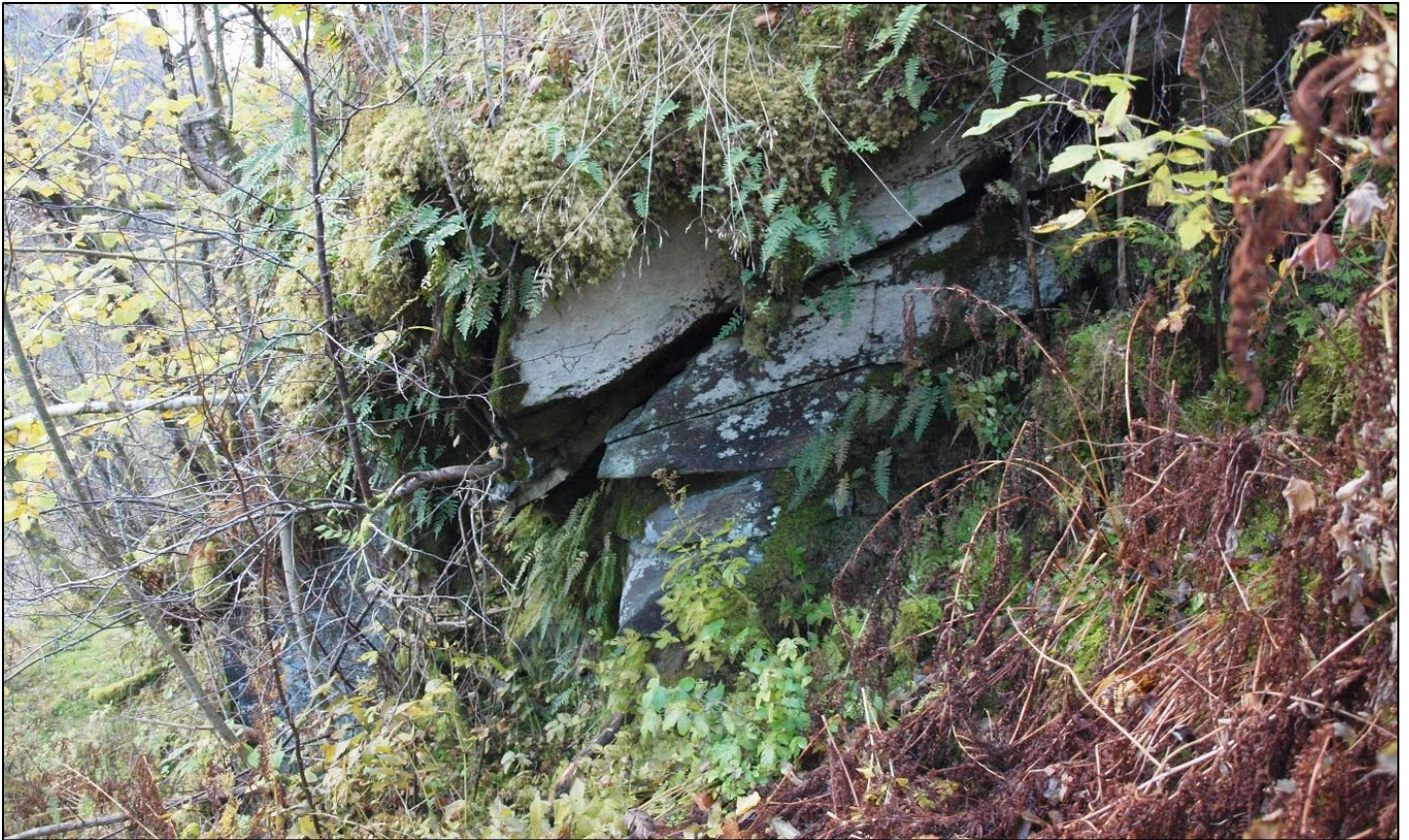
Fig 15. Ustabile løsmasser i planlagt utvidet område.
