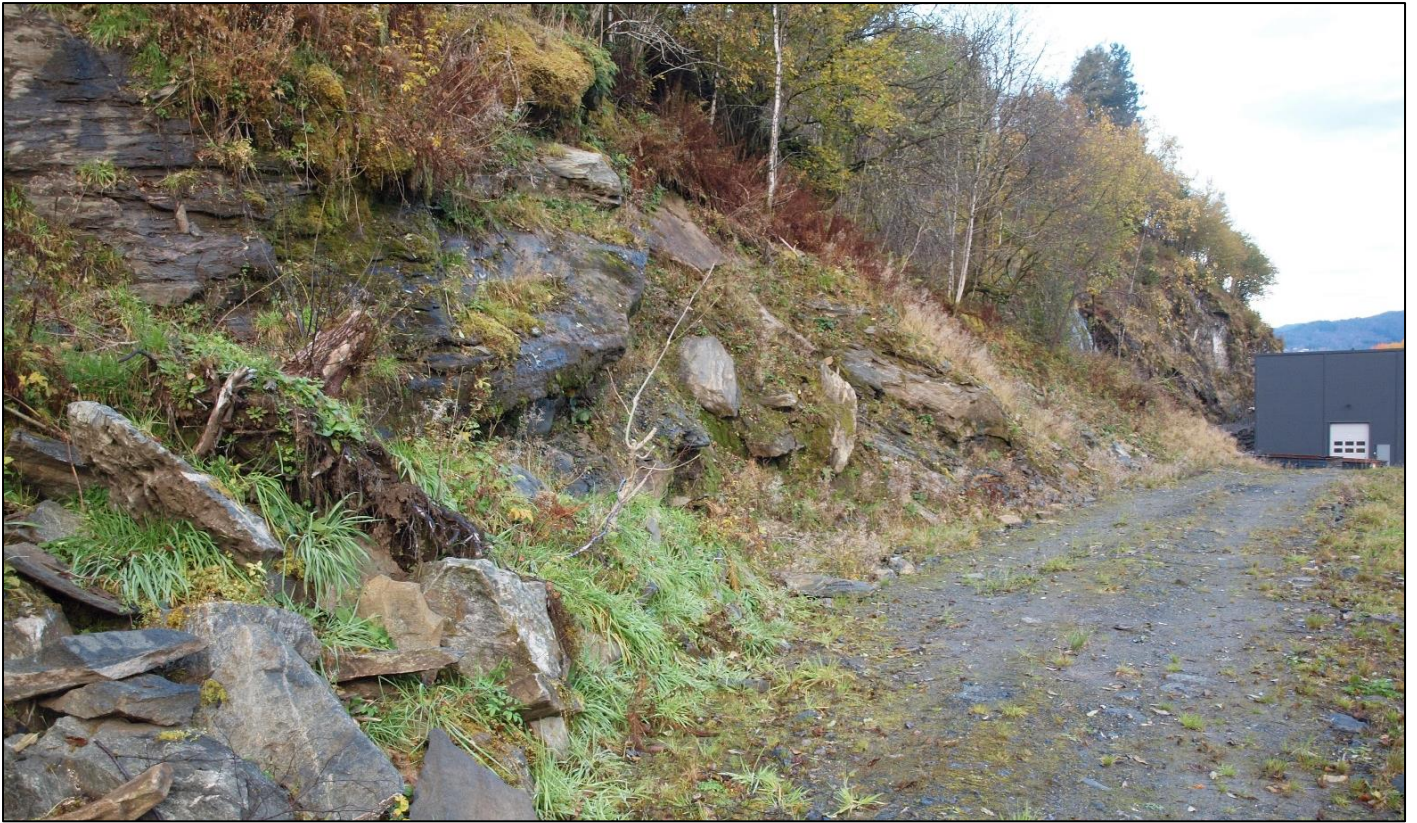
Fig 13. Løsmasser som må fjernes for å avdekke skrentens stabilitet.
