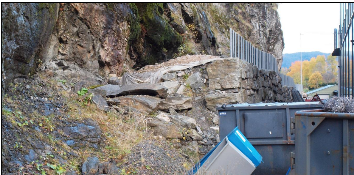
Fig 22. Eksisterende sedimentasjonsgrøft/voll.
