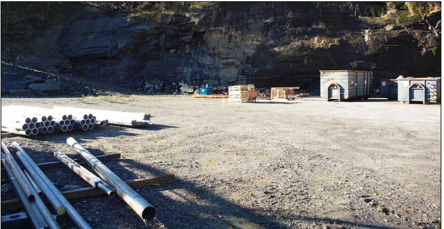
Fig 6. Lagringsflaten sør for bygg i fig 5.
