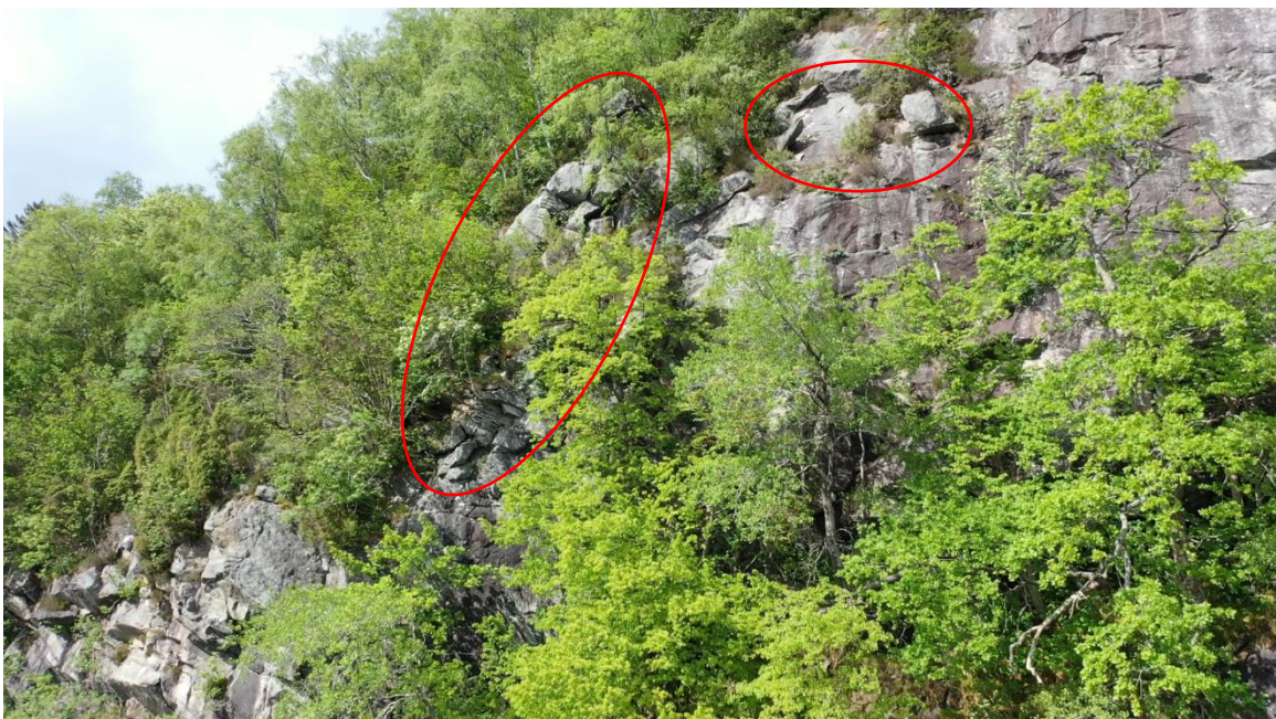
Bilde 3. Avløste og potensielt ustabile bergblokker i fjellveggen nordøst for tomtene. Ringen til venstre markerer avløste blokker som ligger oppstaplet. Ringen til høyre markerer avløste blokker.
