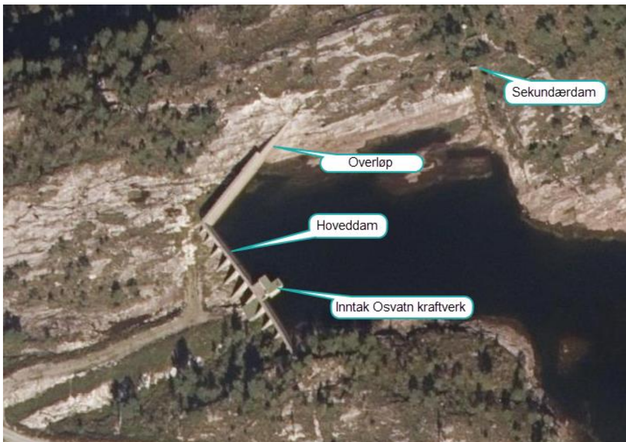
Figur 1- Oversikt over vassdragsanlegget.
