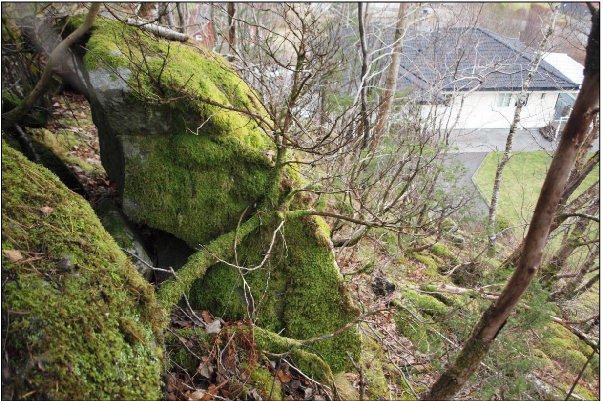
Figur 1-10. Løs blokk over grenseområdet mellom 14/353 og 14/335.
