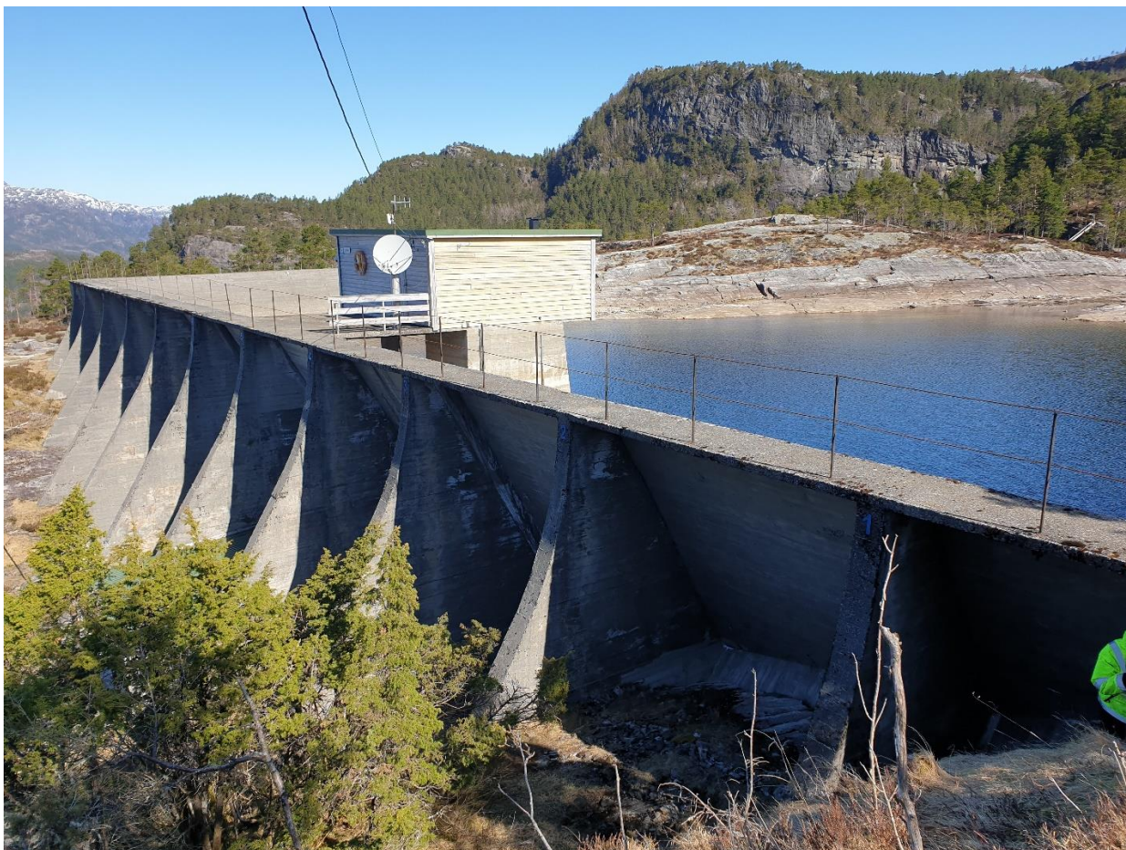
Figur 1-4 Bilde av dammen (Foto: Norconsult)
