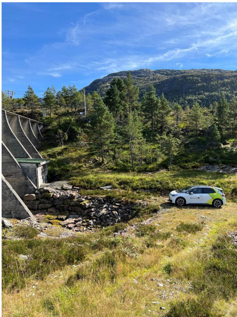
Figur 1-5 Området nedstrøms dam. Det går vei helt fram til dammen. (Foto: Norconsult)
