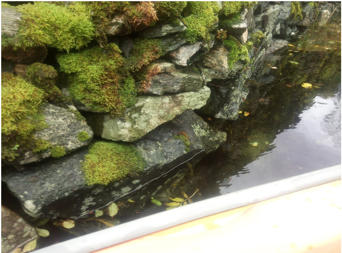
Figur 4 Same som ovanfor: Steinar på veg ut i den nedre delen av murverket
