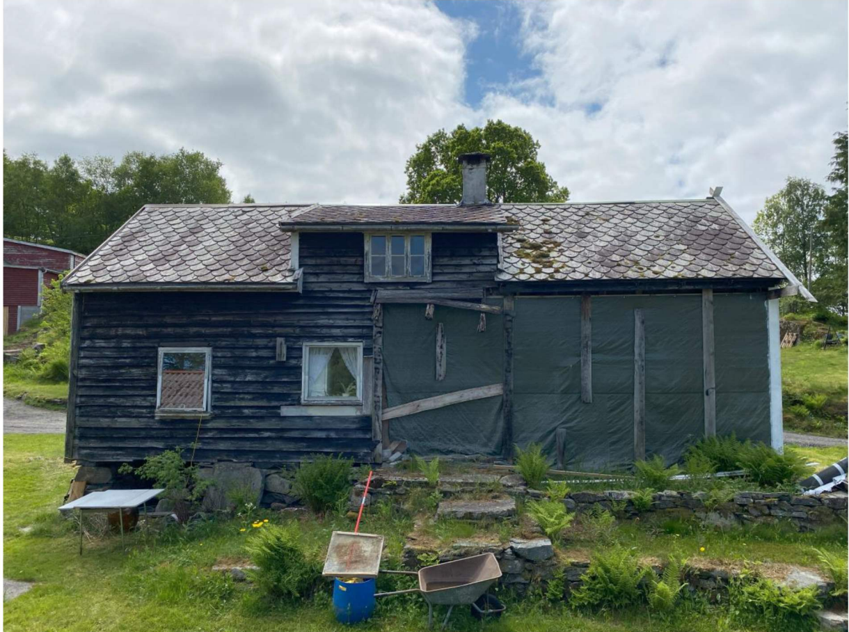
Fasade mot nord-aust
