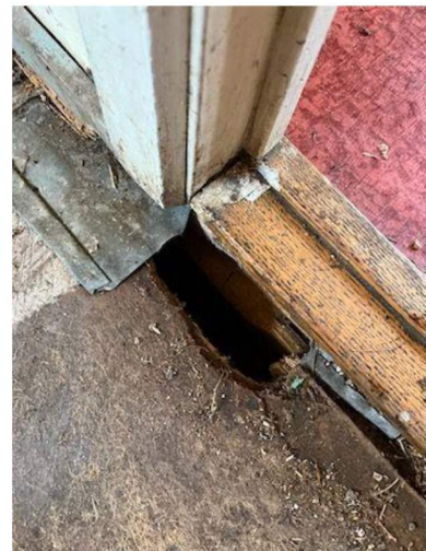
Gjennomgåande råteskade
