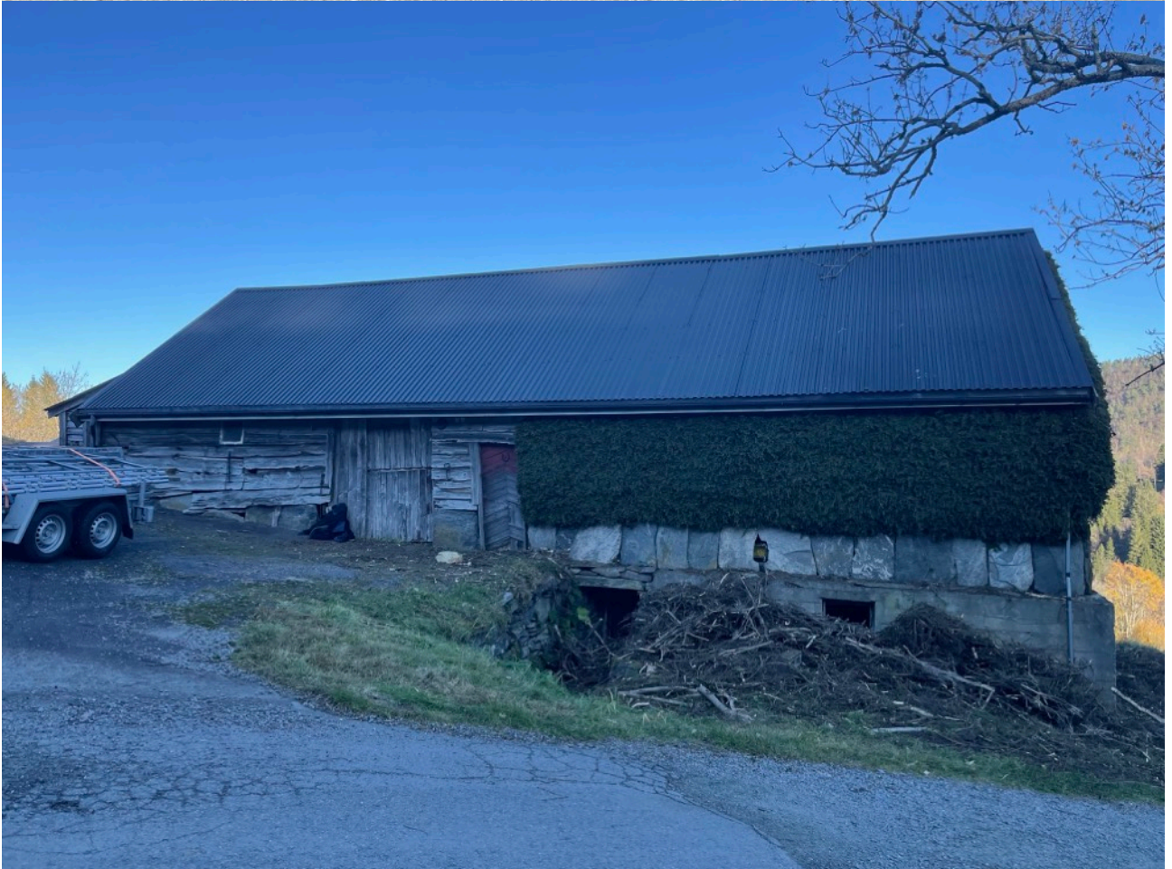
Langveggen mot vegen med gammel og ny kledning.
