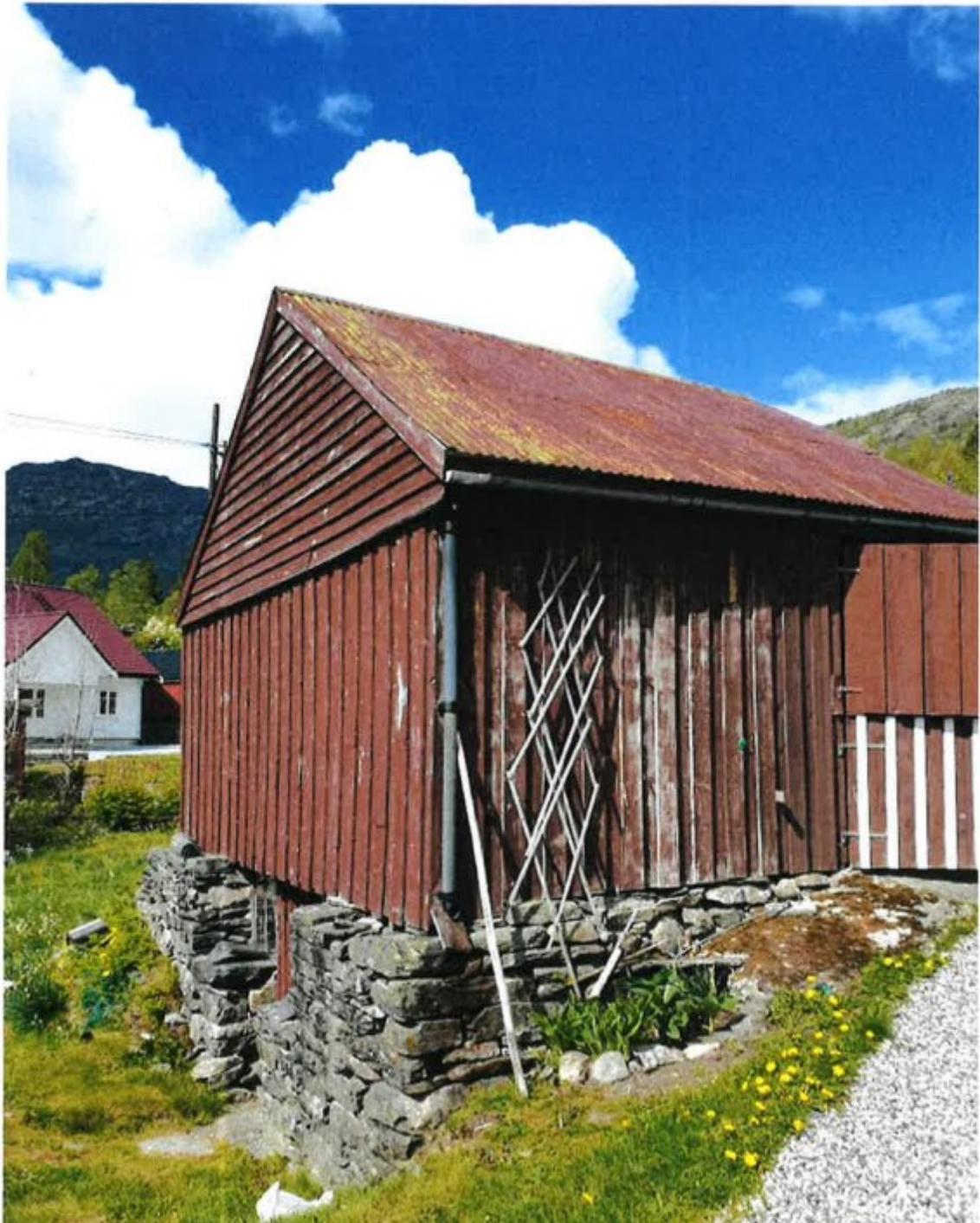
*Bilde av eksisterende tiltak over. Huset står på en gammel stein kjeller som er opptil 1,5 meter høy*
