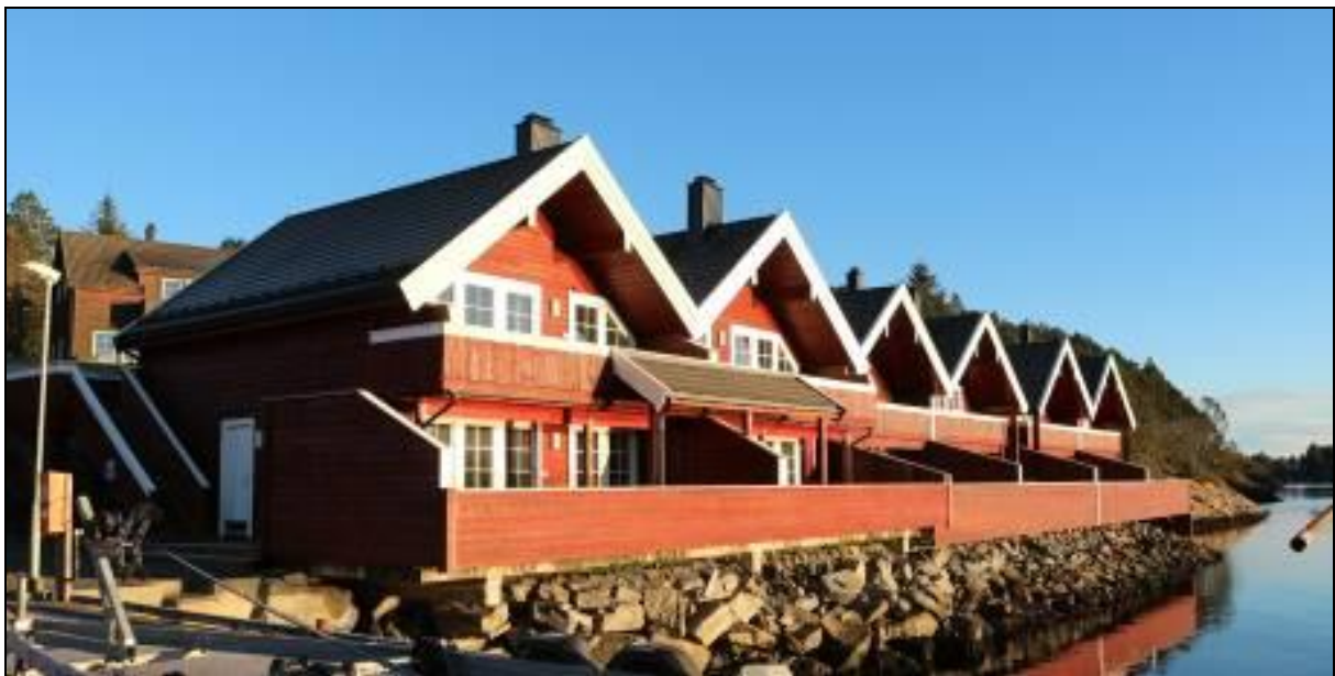
Figur 13: Eksisterande bebyggelse i BFR10 - rorbuer. Planframlegget legg opp til uendra situasjon Foto: Opus Bergen AS
