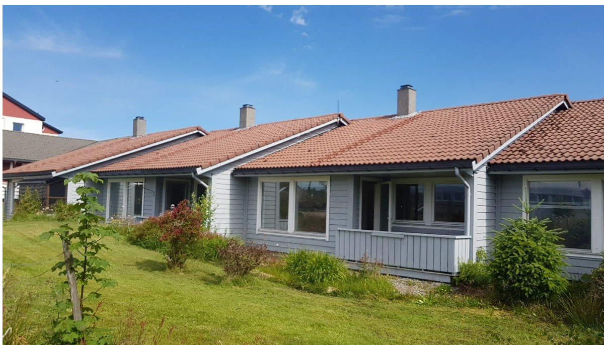
Bilde 1: Fasade omsorgsboliger. Alle enheter har pipeløp forurenset med PAH, samt terrasser i CCA-impregnert treverk
