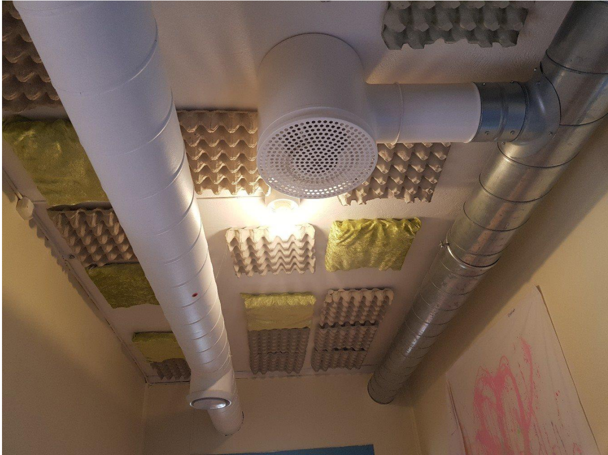
Bilde 6: Nyere ventilasjon i metall
