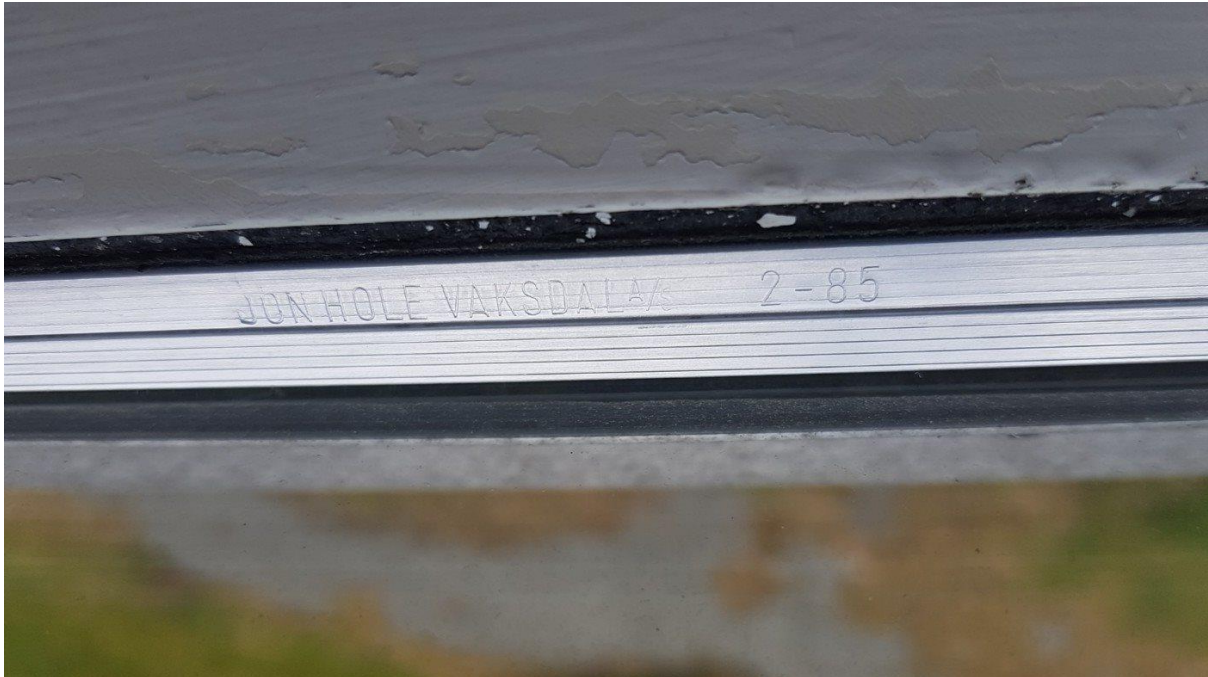
Bilde 2: Isolerglass produsert på 80-tallet må deklarerer og håndteres som klorparafinholdig farlig avfall
