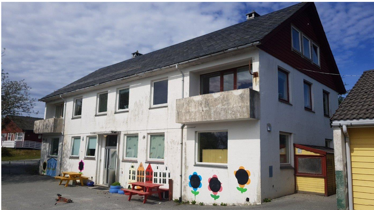
Bilde 1: Fasade tidligere rådhus. Pusset betong, skifer på tak, noe malt panel. Isolerglassruter av varierende produksjonsår, alle unntatt 2 stk i 1. etg er av nyere dato, de fleste resterende datert 80-tall og dermed å betrakte som klorparafinholdig farlig avfall. CCA-impregnert treverk i tilknytning til terrasser i 2. etg.
