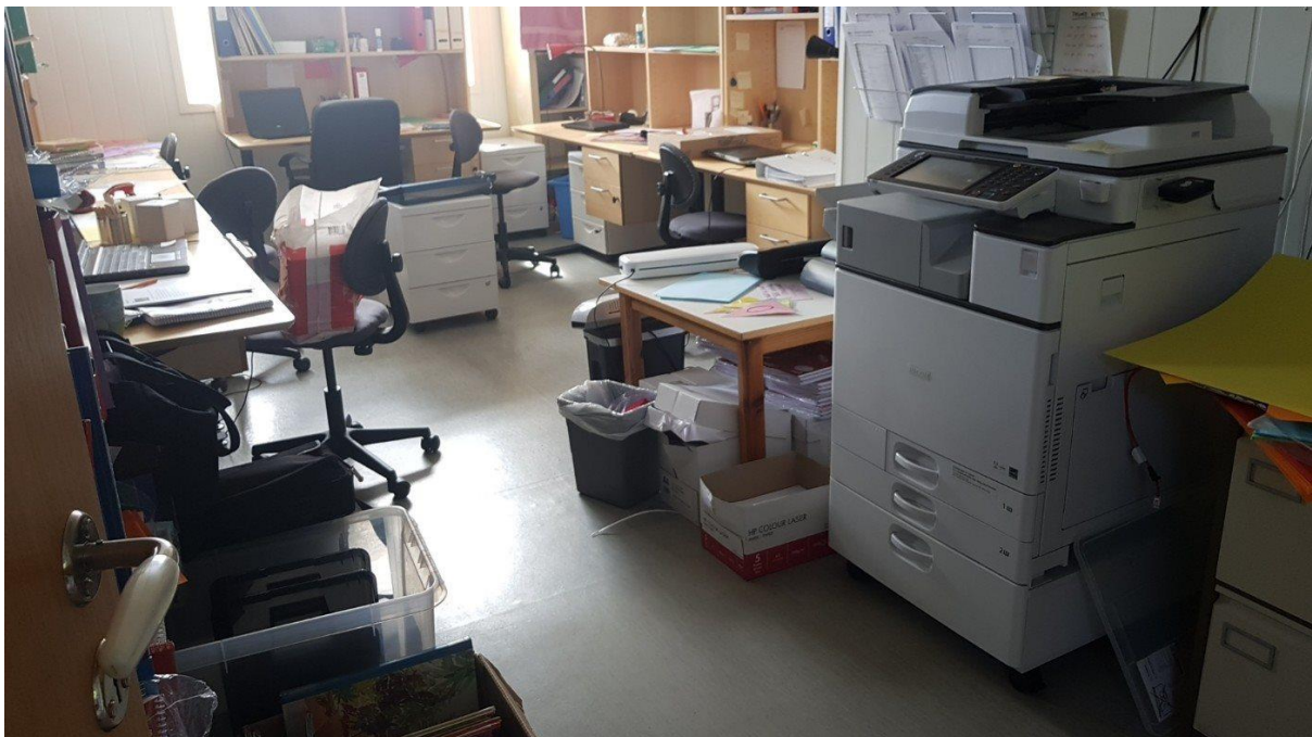
Bilde 3: Innvendig er det stedvis ftalatholdig gulvbelegg. Alt gulvbelegg må deklarerer og leveres til godkjent mottak for farlig avfall
