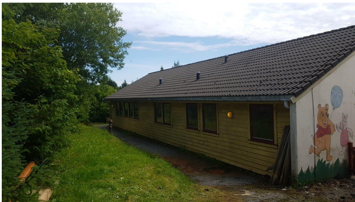
Bilde 1: Fasade bakside av bygget. Takstein på tak, klorparafinholdige isolerglassruter.
