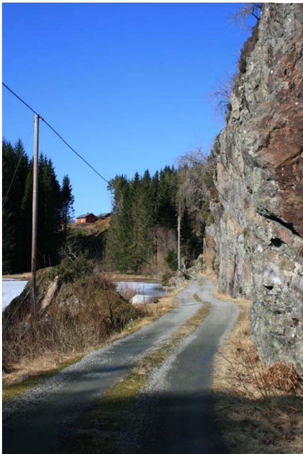
Figur 11. Parti av eksisterende tilkomstveg til Snekkevika, Kjesettjørna til venstre på bildet. Foto mot vest.
