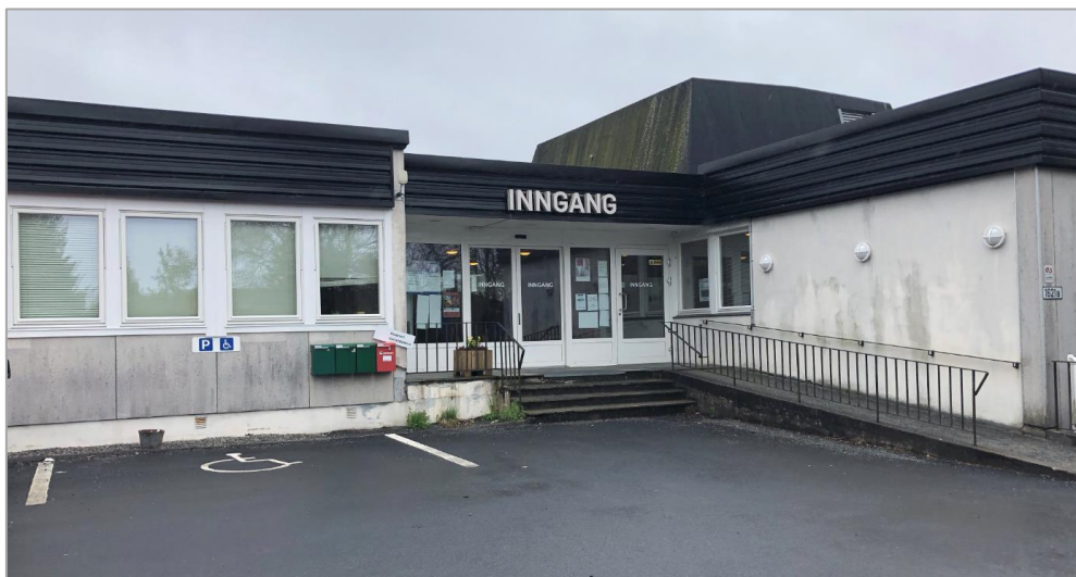
Figur 18. Hovudinngang til helsehuset, med HC-parkering og rampe.
