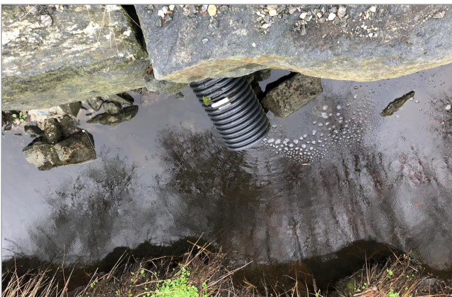
Figur 24. Eit av fleire røyr med utslepp av vatn frå næringsområdet til bekken.
