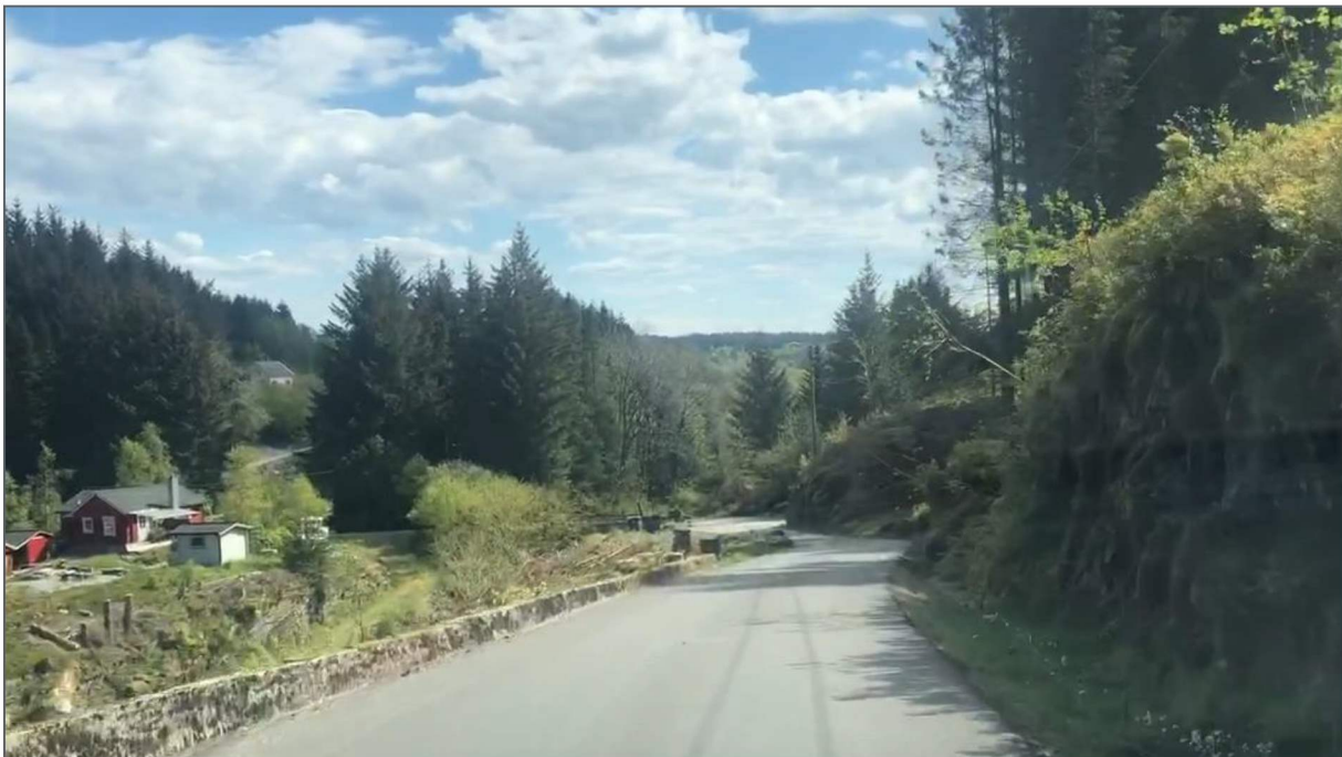
Bilete 21: Bilete frå strekninga ved Støvleringen på kv. 6052 Listveitvegen, fartsgrense 50 km/t. Her er det skjeringar og bratte fyllingar der det er liten eller ingen plass på utsida av vegen.
