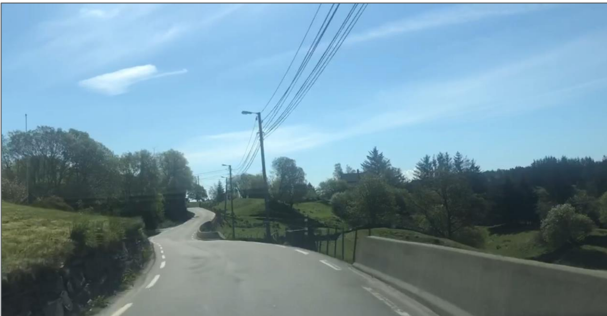
Bilete 9: Bilete frå strekninga Nesøbø til fartsgrense 30 km/t sør-aust for Austebyd skule på fv. 565 Slettevegen, fartsgrense 50 km/t. Vurdert som særleg farleg/vanskeleg strekning for 1. og 2. klasse
