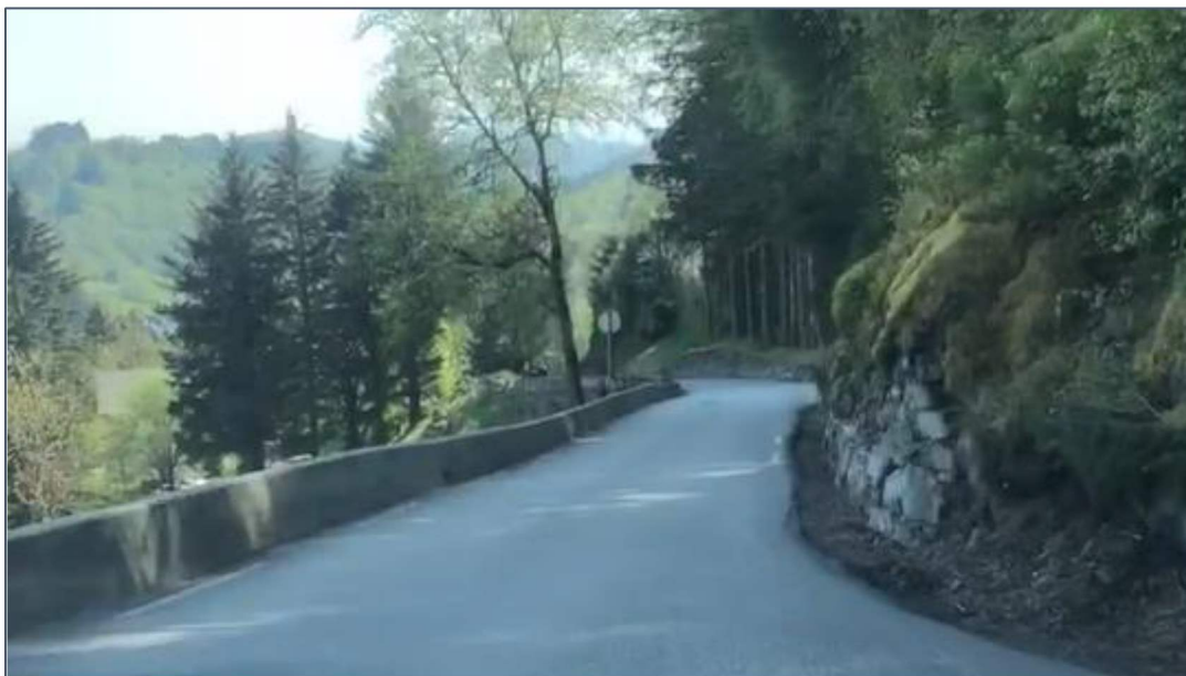
Bilete 2: Smal veg med krapp kurvatur. Det er skjeringar og betongrekkverk der det er liten eller ingen plass på utsida av kvitstripa på fv. 565 Solendvegen
