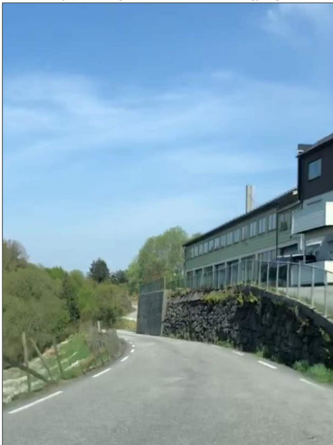
Bilete 3: Krappe kurve med dårleg sikt, skjeringar og fyllingar, med liten eller ingen plass på utsida av kvitstripa på fv.409 Radøyvegen retning nord, fartsgrense 50 km/t.
