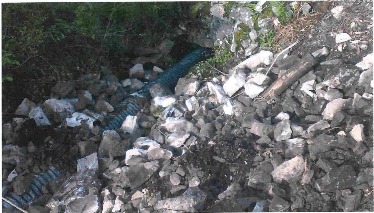
Fig. 5. Bilde tilsendt frå Jonny Hjelle den 30.09.14 og som syner situasjonen i samband med nedlegging av røret. Bildet er teke 22.09.11.
