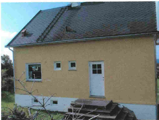
Fasade mot sør, der tilbygget kjem.
