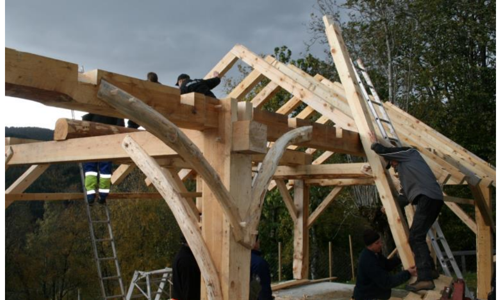
Grinder og takstolar på plass (over). Det vert nytta trenagle i staden for spikar (under).
