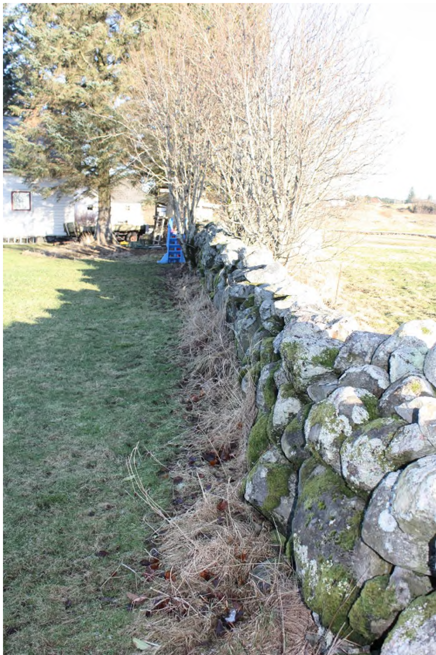
Figur 22 Steingard langs sørleg planavgrensing
