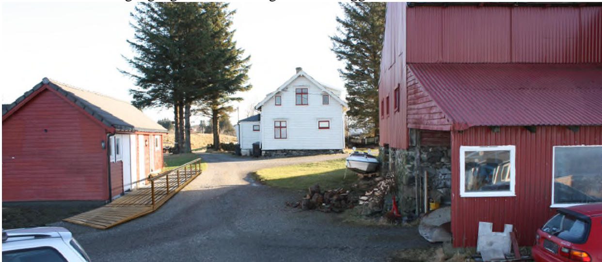
Figur 30 Fotomontasje, sanitæranlegg til venstre i bilete.
