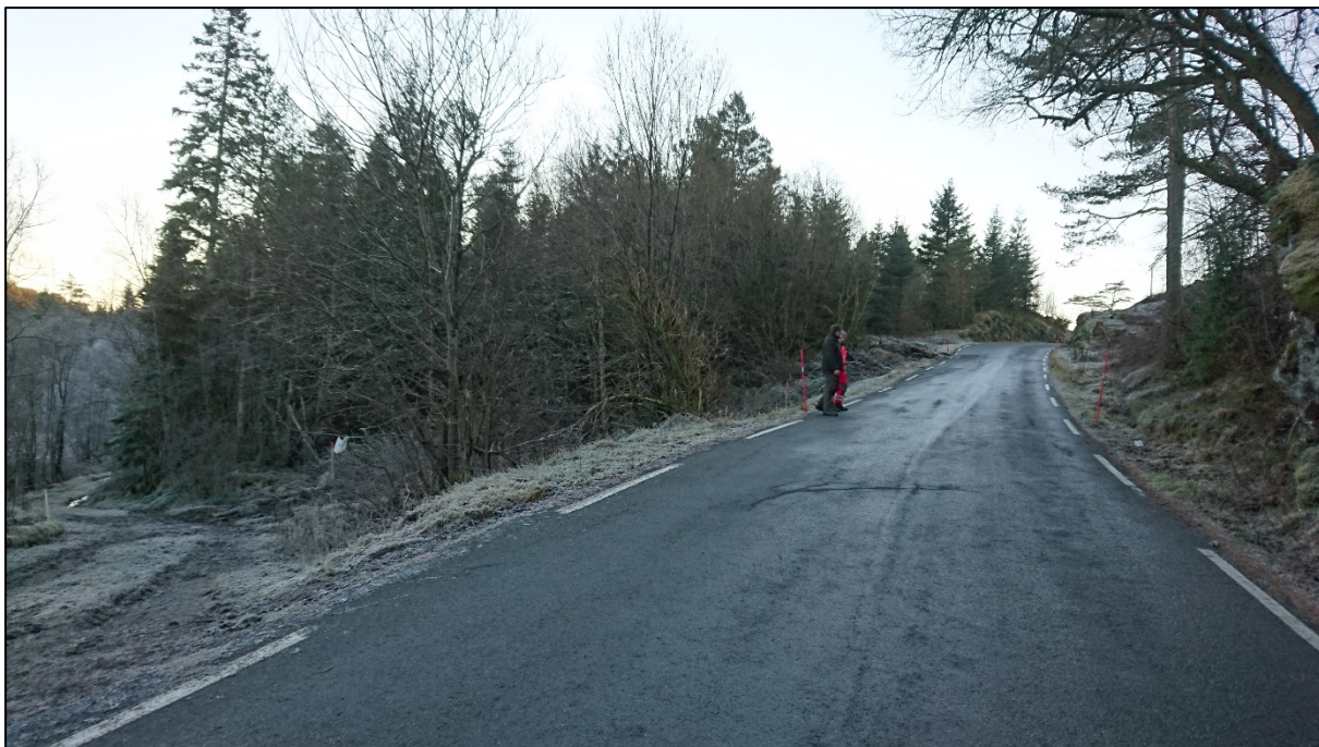
Figur 5 Fv. 411 som nye fv. 565 skal krysse over med ei 25 meter lang bru om lag der personane i biletet står. Her vil det bli avkjørsel og nærleik til innfartsparkering og busshaldeplassar. Det er uklart om denne undergangen vil egne seg som viltpassasje. Foto: Magnar Bjerga, Statens vegvesen.
