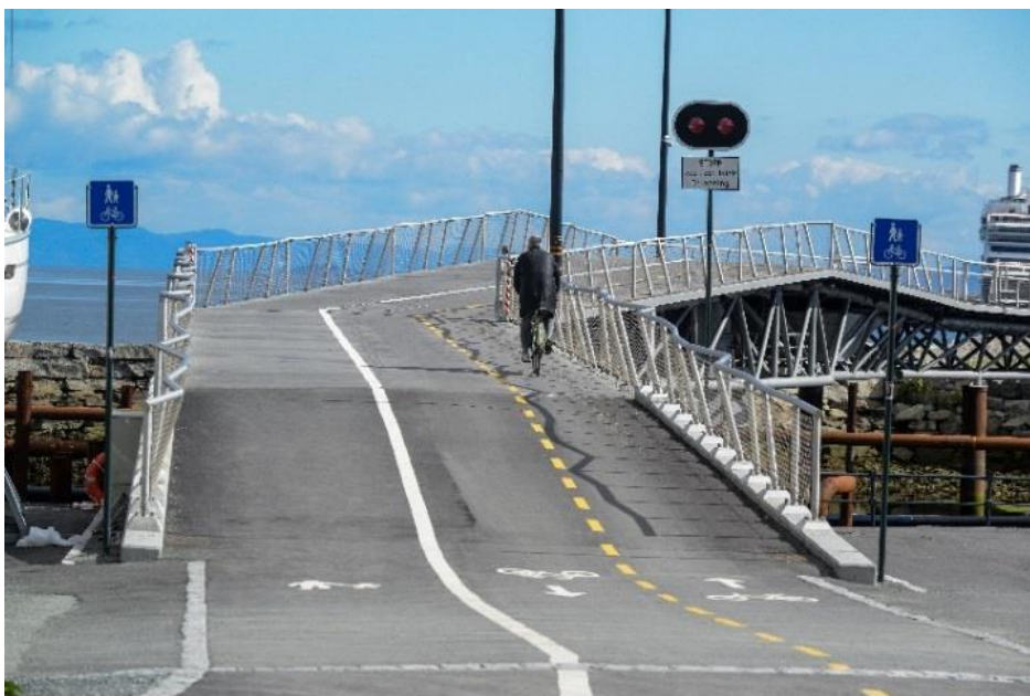
Skansen Bru inn mot Brattøra/Trondheim S. Foto: Knut Opeide
