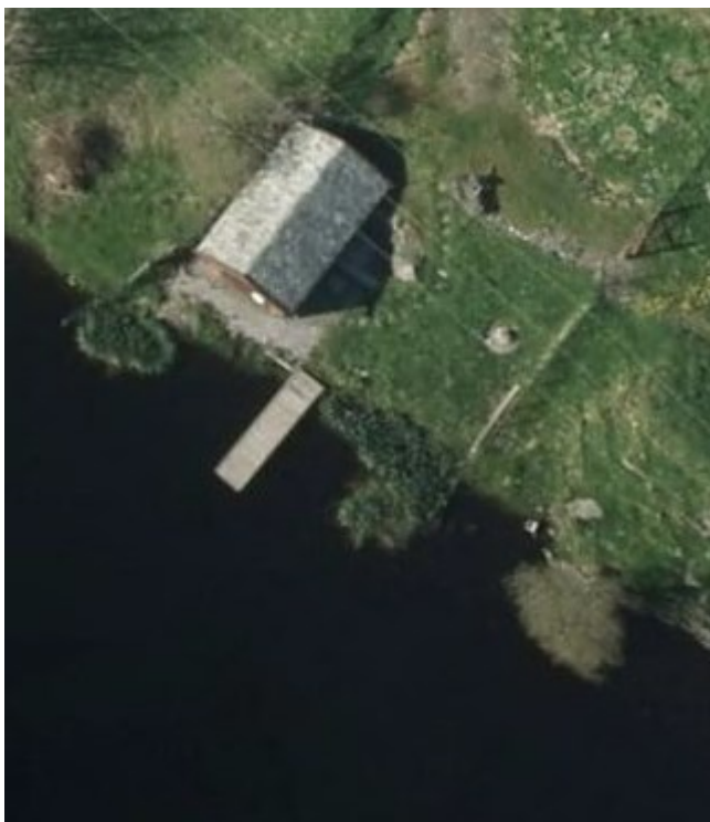
Flyfoto av flytebryggje og båtnaust/vedlager
