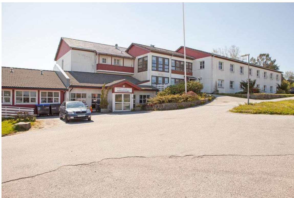
Bildet ovenfor syner dagens noko utflytande trafikkareal i Nordbøvegen med felles avkøyring, parkering og droppsoner. (Kilde: Radøy Kommune)
