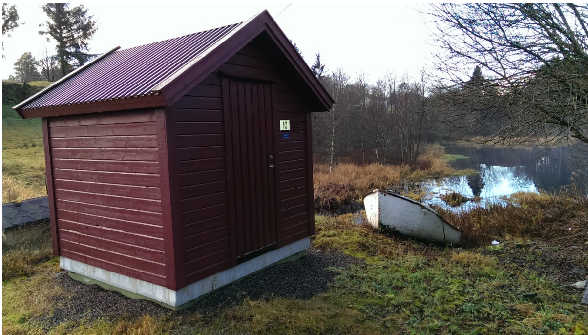
Bilde 3 Pumpestasjon ved Ystebø
