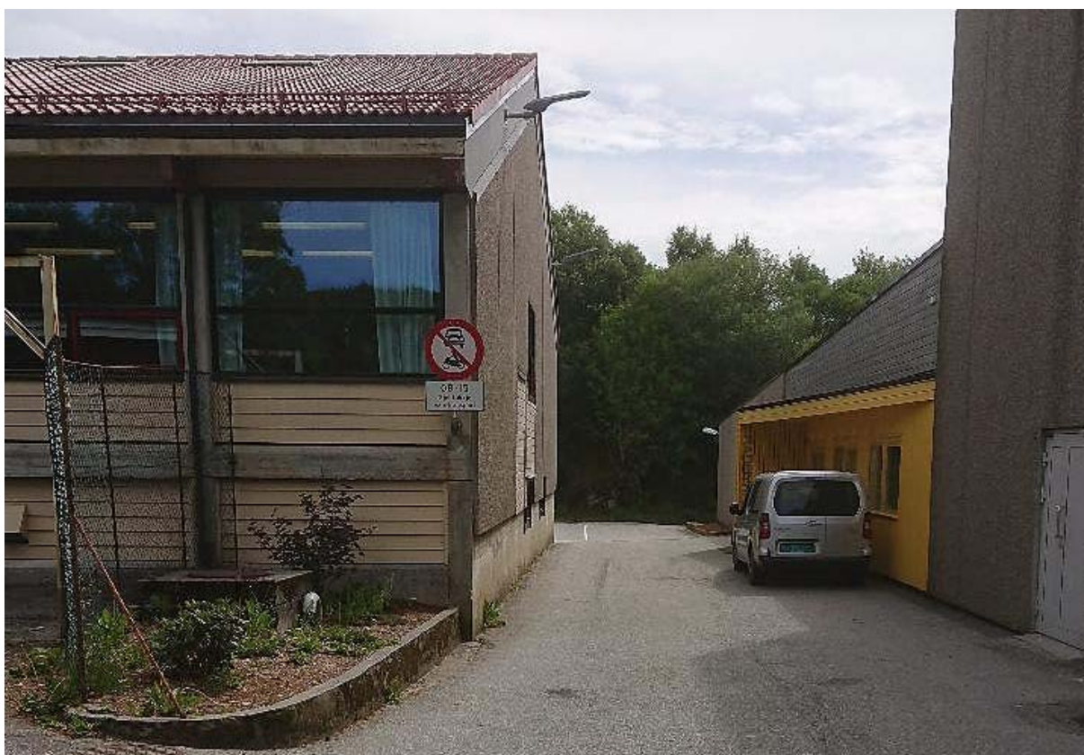
Figur 12 Trong passasje mellom ungdomsskule og Radøyhallen, like ved hovudinngangen til hallen.
