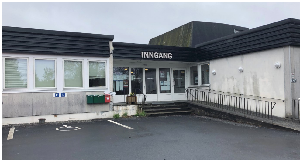
Figur 18. Hovudinngang til helsehuset, med HC-parkering og rampe.
