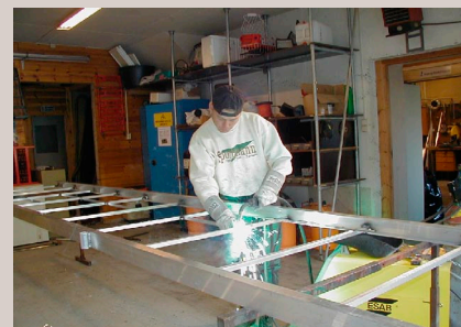
Rampe av aluminium under arbeid.
