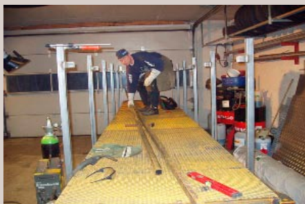
Rampe av stål under arbeid.
