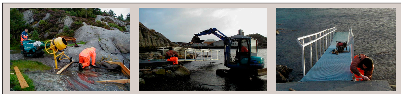
Fundamenter klar til støping. Husk armering.
