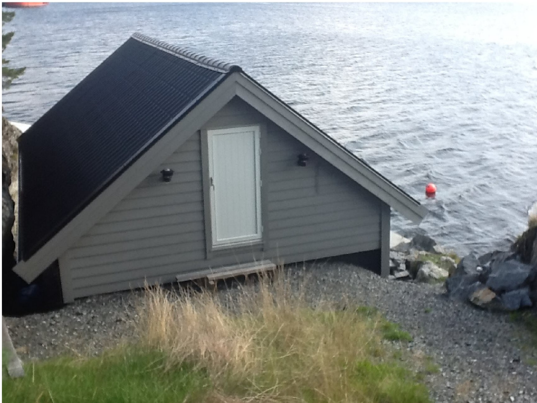
Fasade mot sør, oppfylling av terreng mot bakvegg i 1.etasje
